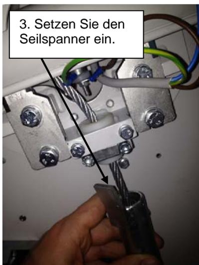
3. Setzen Sie den Seilspanner ein.
