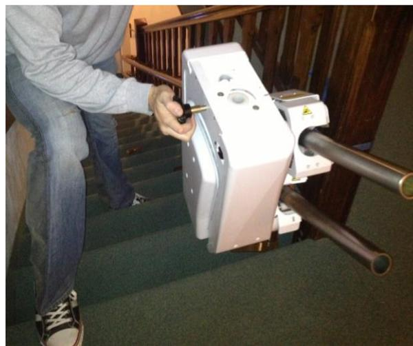
**Schritt 3:** Nehmen Sie die vordere und seitliche Plastikabdeckung ab. Danach fixieren Sie den Stuhl und befestigen ihn mit einer Schraube und Beilagscheibe im Inneren der Fahrereinheit.
