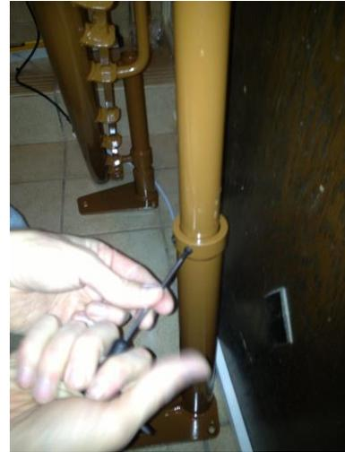
**Schritt 6:** Wenn alle Schienenteile verbunden sind, sowie alle Stützen fixiert, überprüfen Sie nochmals alle Maße und die gesamte Position der Schiene anhand des Installationsplans.
